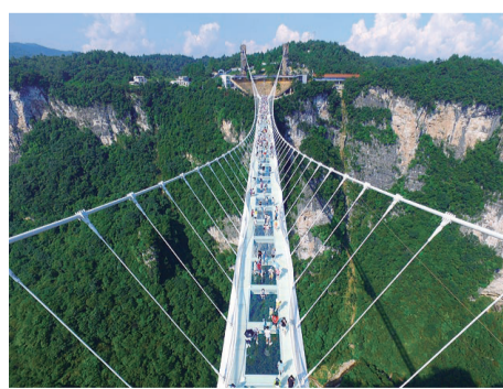
Mise à l'essai, le 20 août dernier, du pont à fond de verre de Haim Dotan.
